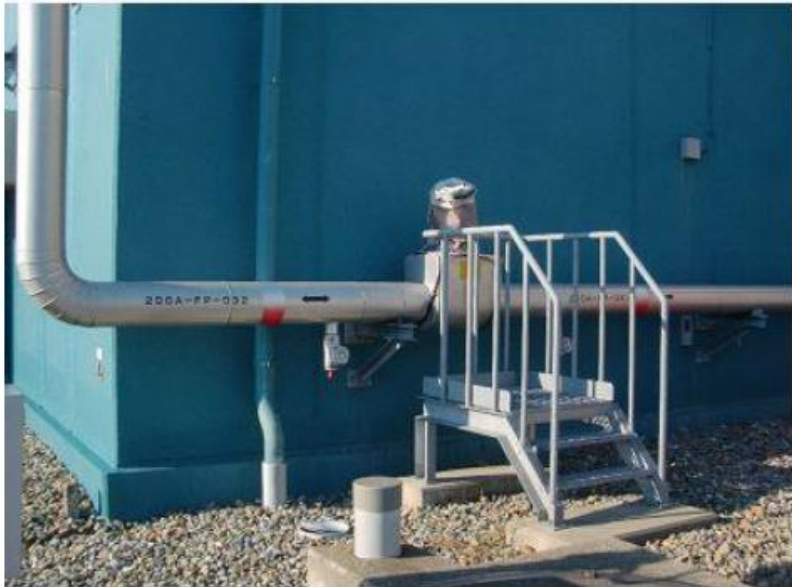
第 1-31 図：屋外消火配管への保温材設置状況
