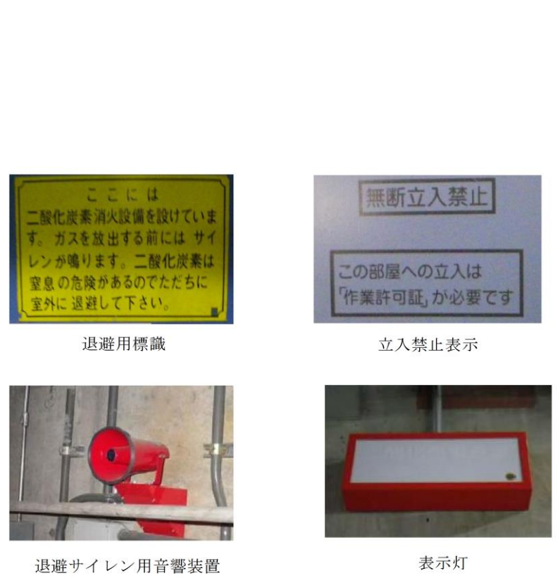
第1-32図 二酸化炭素自動消火設備（全域）の退避警報装置の例
