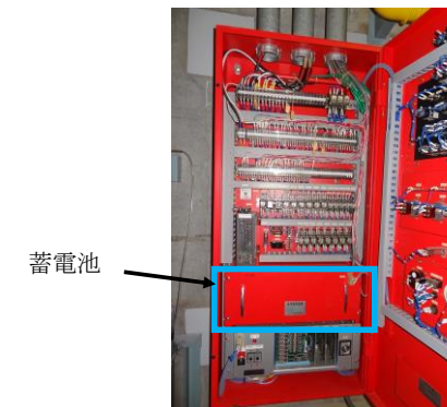
第1-28図 消火設備の電源確保の概要
