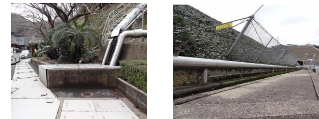
第 1 -32 図 屋外消火配管への保温材の設置状況
