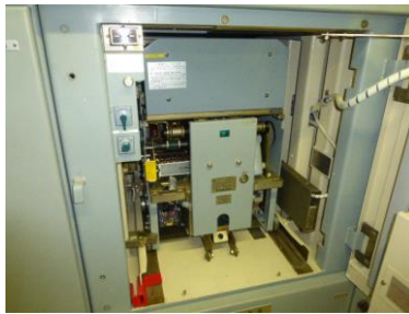
気中遮断器の例 (ロードセンタ)
