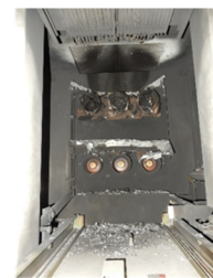
盤内開口部の状態(遮断器室)
