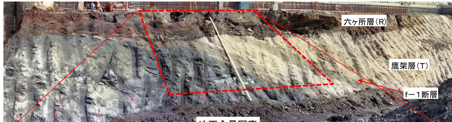
法面全景写真
