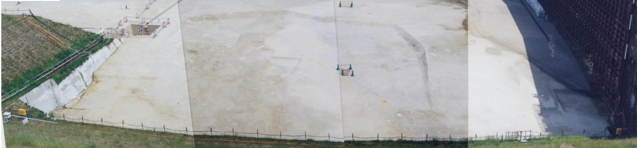
基礎掘削面全景(南側から望む)
