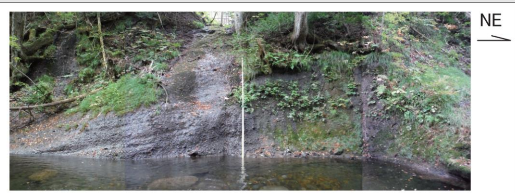
露頭状況写真 (右②)
