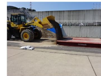
第6図 段差復旧状況
