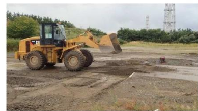
段差復旧状況③
