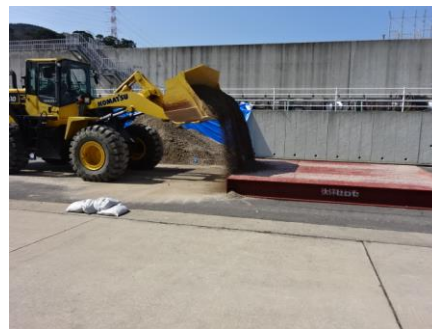
第6図 段差復旧状況
