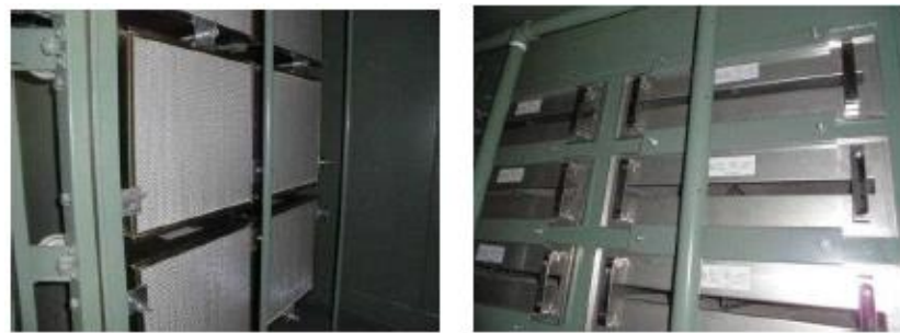
(高性能フィルタの取付け状態) (活性炭フィルタの取付け状態)
