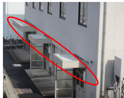
176 3号館管理事務所
