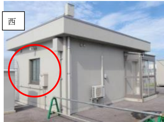
148 北口建物西側ガラス窓
