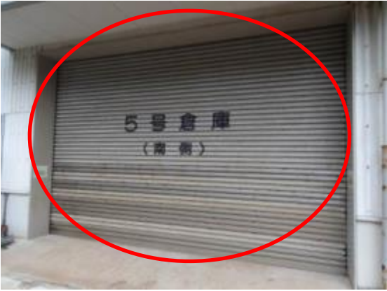
90 5号倉庫南側シャッター
