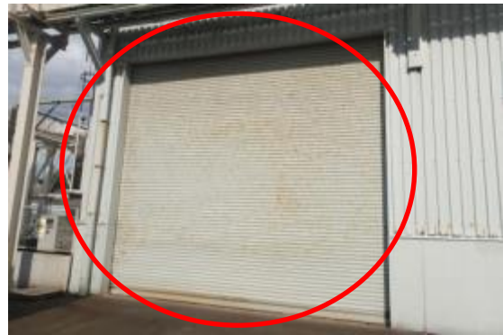
95 1号開閉所西側シャッター
