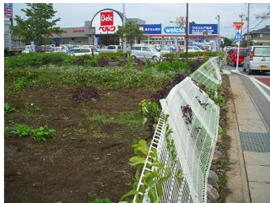
写真31 フェンスの変形
