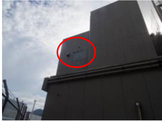
69 サイトパンカ建物ガラス窓（2）
