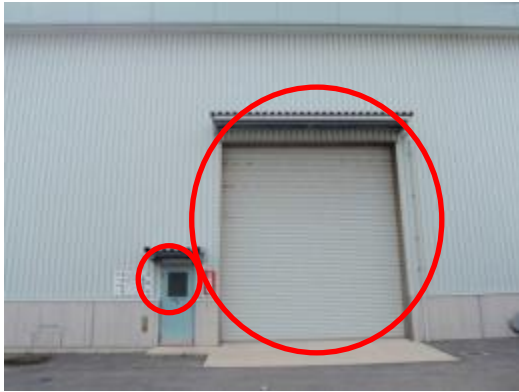
120 補助ボイラー建物東側シャッター，ガラス窓
