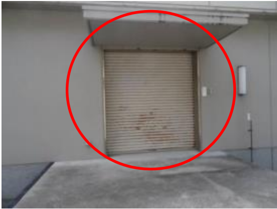
70 危険物屋内貯蔵所東側シャッター
