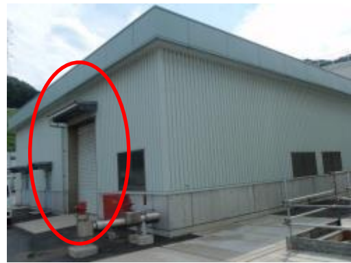
138 給水設備建物東側シャッター
