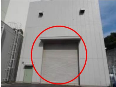
65 サイトバンカ建物西側シャッター
