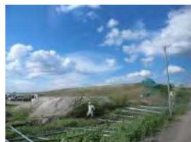
フェンスの被害
