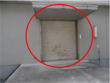
70 危険物屋内貯蔵所東側シャッター
