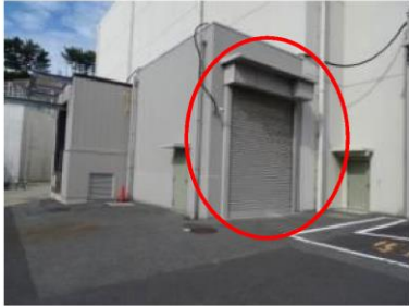
66 サイトバンカ建物南側シャッター
