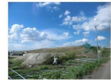
フェンスの倒壊
