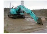
③-14 建設重機 (バックホー)
