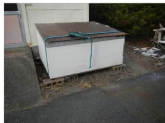
#350 鋼製ボックス
