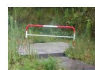
③-9 鋼製フェンス
