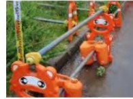
③-2 鋼製車止め (単管バリケード)
