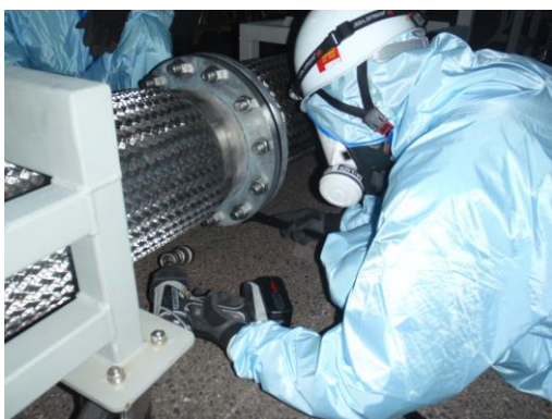
ホース接続作業
