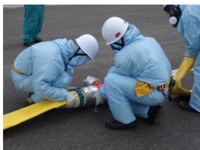
ホース接続作業（昼間）
