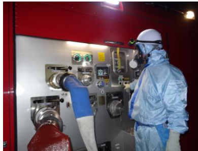
ポンプ起動操作（夜間）
