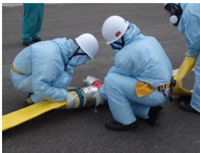
ホース接続作業（昼間）
