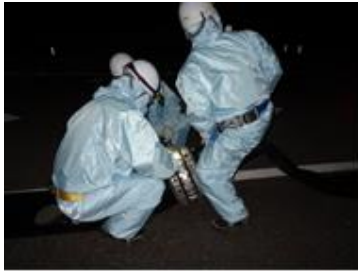
ホース接続作業（夜間）
