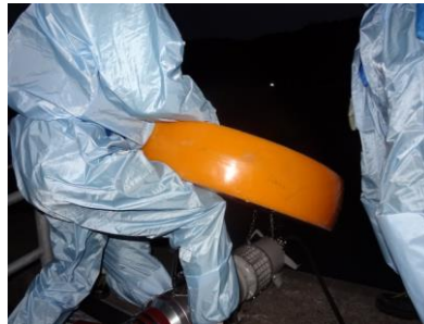
水中ポンプ設置準備（夜間）
