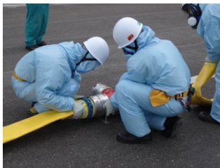
ホース接続作業（昼間）
