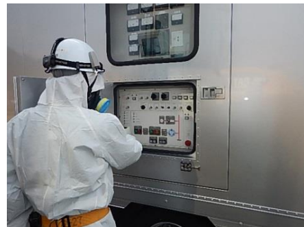
高圧発電機車での作業
