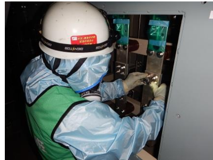
ボルトリンク接続作業
