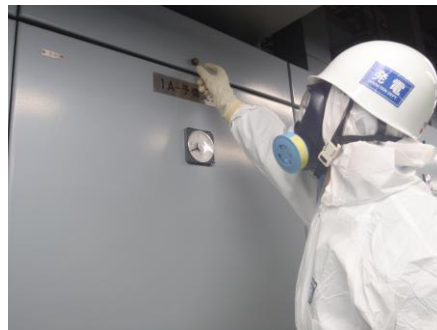
インターロック解除処置
