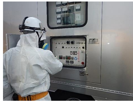
高圧発電機車での作業
