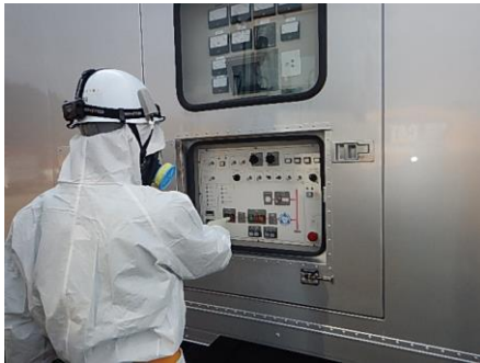
高圧発電機車での作業
