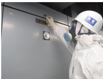
インターロック解除処置
