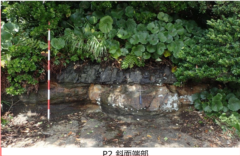
斜面端部は黒色頁岩・凝灰岩の互層, C H 級である。
