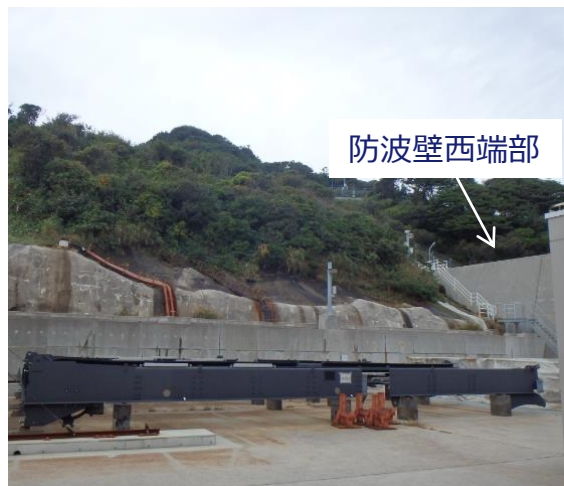
防波壁西端部 状況写真
