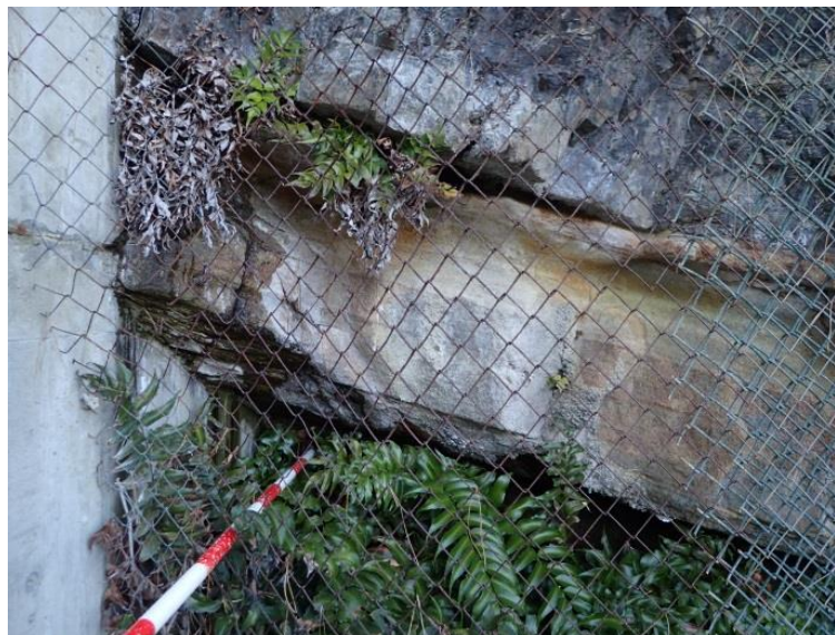
P2 防波扉北側岩着部拡大 岩盤に崩壊するような緩みや高角度亀裂等の 顕著な変状は認められない。
