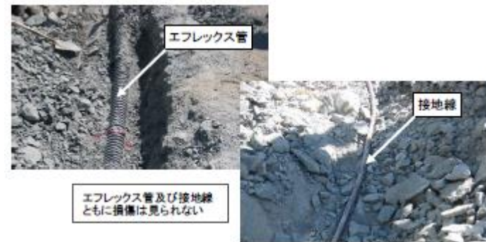
第19 図 地盤改良後のエフレックス管及び接地線状況
