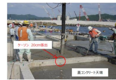
第6図 防波壁 (波返重力擁壁) ケーソンの施工状況
