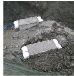
ドレーン(U字溝)設置状況
