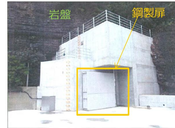
第1-48 図 防波壁通路防波扉 (1号放水連絡通路防波扉) ⑤ 設置状況
