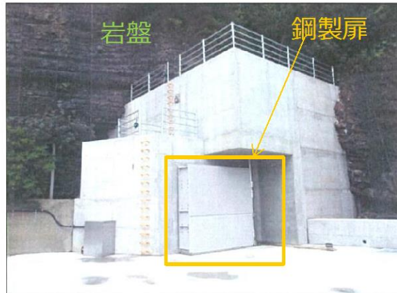
第 1-48 図 防波壁通路防波扉（1号放水連絡通路防波扉）⑤ 設置状況
