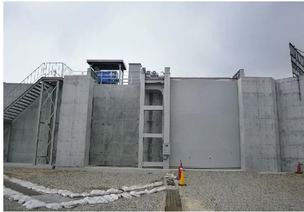
第 1-47 図 防波壁通路防波扉（1，2号炉北側）④ 設置状況
