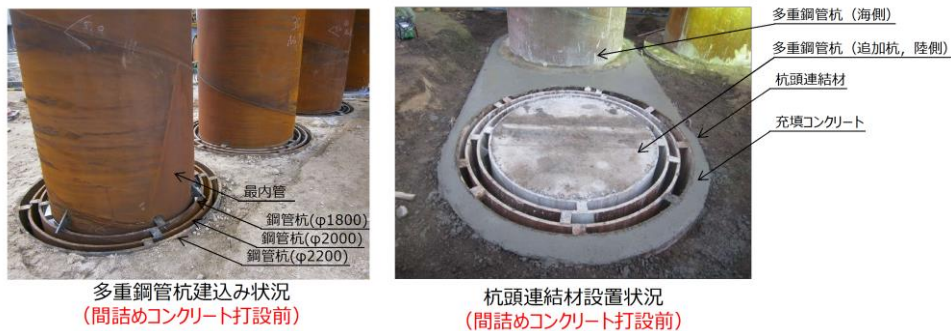
第1図 杭頭部の状況
