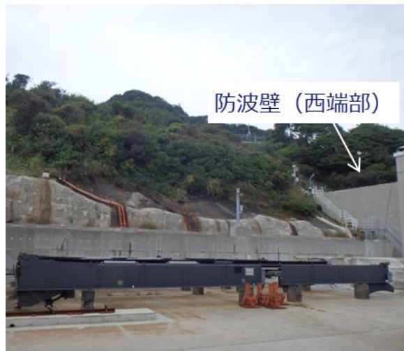
図 2 - 21 防波壁西端部 状況写真
