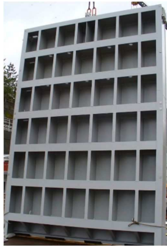
図 1 6 取水路下流側から見たゲート扉体の構造
