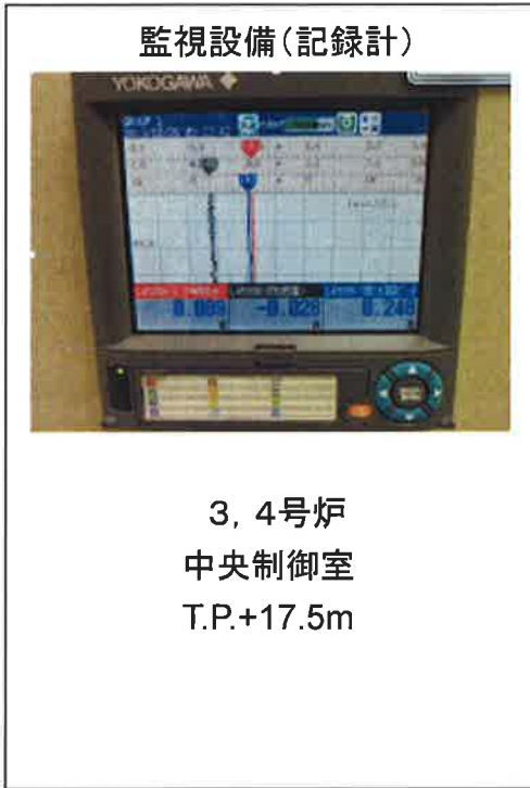
図 3-3-5 (2/2) 潮位計設備構成イメージ
