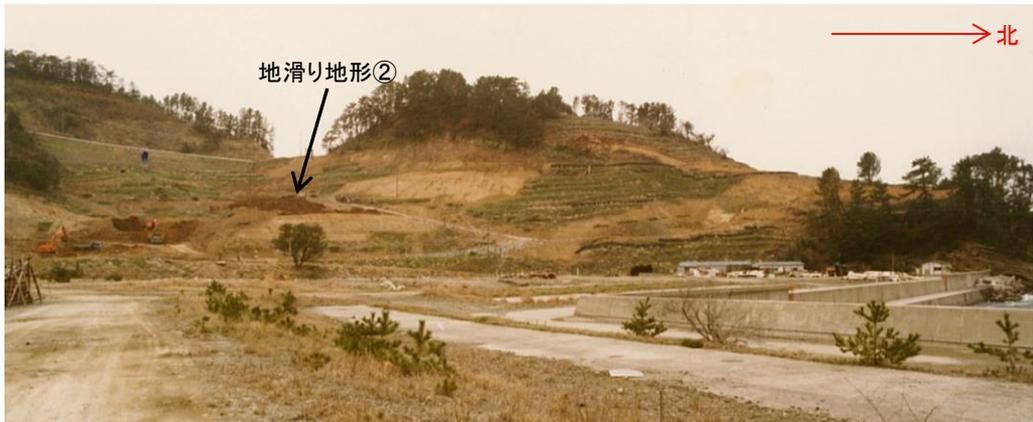
P7 土地造成工事状況写真 (置換盛土施工時) 1983年撮影
