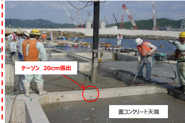
蓋コンクリート打設状況
