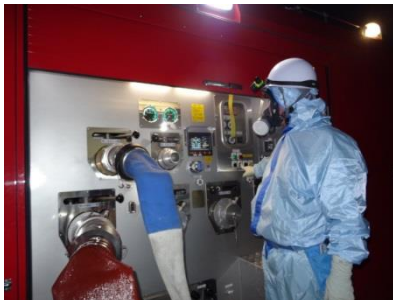
ポンプ起動操作（夜間）
