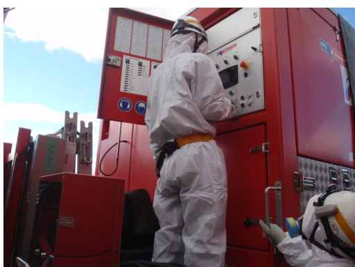
ポンプ起動操作
