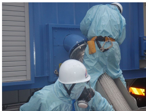
移動式代替熱交換設備へのホース接続作業
