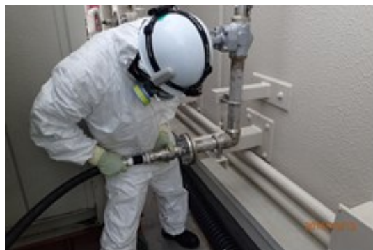
ホース接続作業
