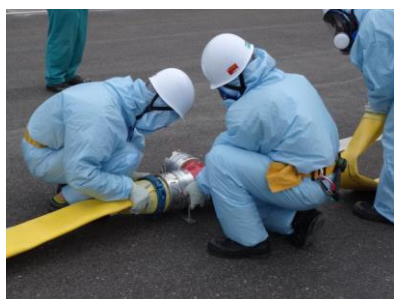
ホース接続作業（昼間）
