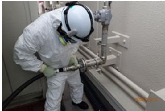
ホース接続作業
