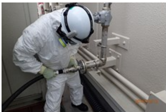
ホース接続作業
