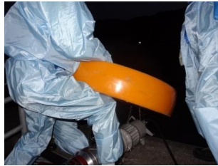
水中ポンプ設置準備（夜間）
