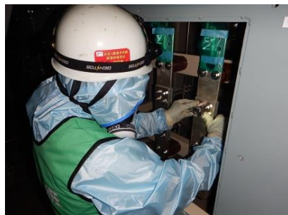
ボルトリンク接続作業
