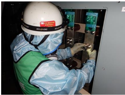
ボルトリンク接続作業
