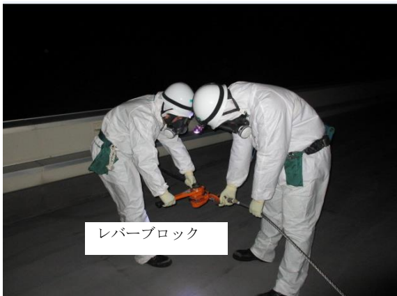
ワイヤー，レバーブロック接続作業
