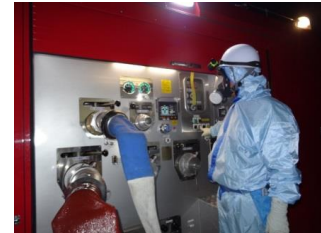
ポンプ起動操作（夜間）
