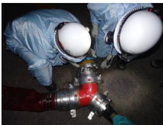
ホース接続作業（夜間）
