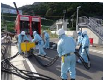
水中ポンプ設置準備（昼間）
