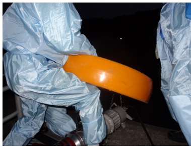
水中ポンプ設置準備（夜間）
