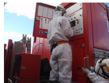
ポンプ起動操作
