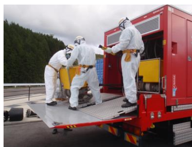
水中ポンプ設置準備
