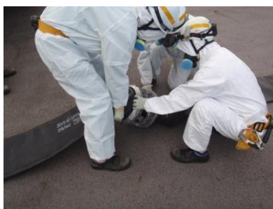
ホース接続作業
