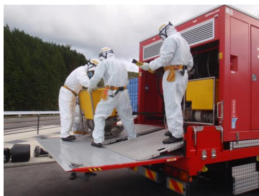
水中ポンプ設置準備
