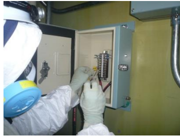
ADS 仮設電源接続 中継端子箱へ接続
