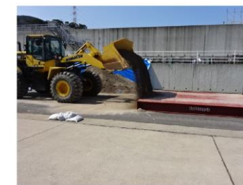
第6図 段差復旧状況
