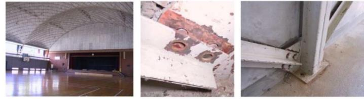
内観 筋かい材ボルト破断 間柱脚部アンカーボルト破断
