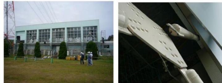
外観 筋かい材プレート破断
