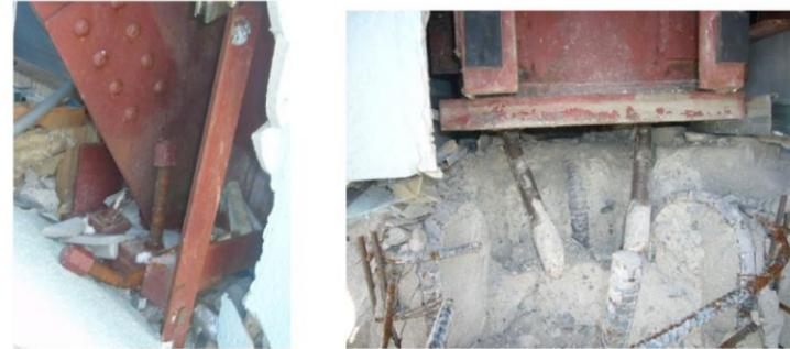
アンカーボルト引き抜け 柱脚部コンクリート破壊
