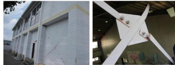
筋かい材の変形
