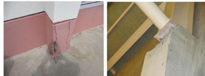
柱脚部コンクリートのひび割れ
