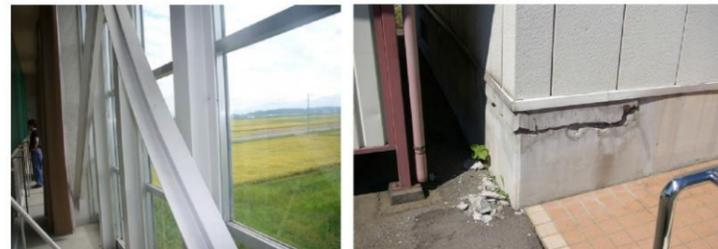
筋かい材の座屈 (刈羽村) 柱脚部コンクリートの割れ・剥落 (長岡市)
