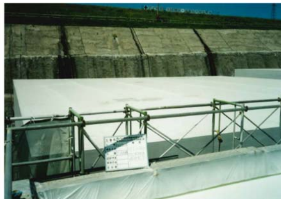
仕上げ材吹付け
