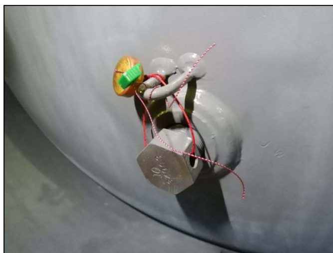
査察封印のき損の状況
