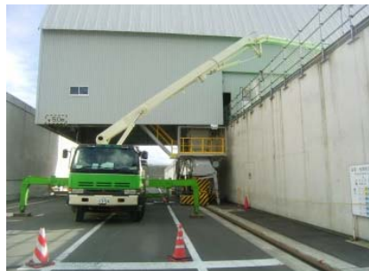
第4図 埋設設備内への充填材充填
