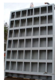
【取水路下流側から見えたゲート扉体】
