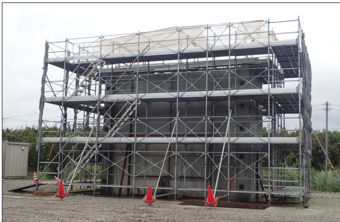
第 21 図 実証試験供試体の外観
