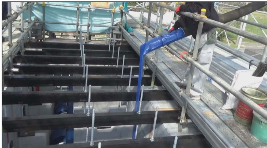
第 25 図 充填モルタル打込み状況
