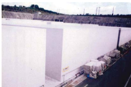
写真4 表面被覆状況(1号4-C)
