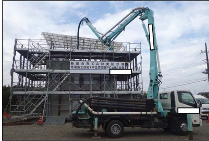
第 23 図 モルタル打設方法
