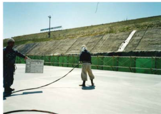
防水材吹付け
