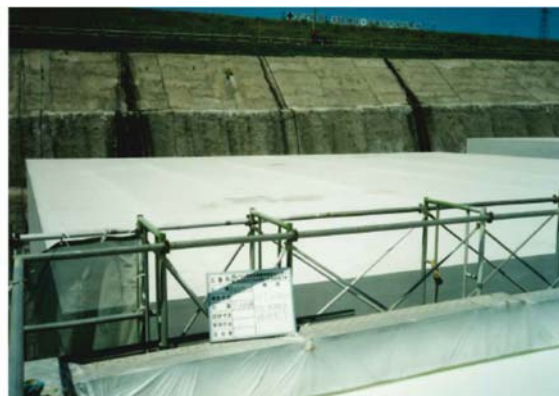
仕上げ材吹付け
