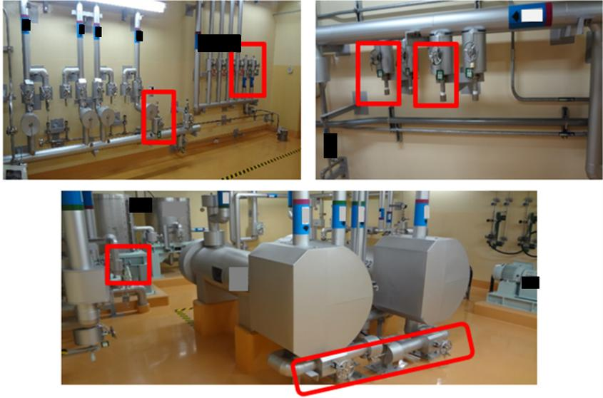
第 1. - 8 図 ウラン・プルトニウム混合脱硝建屋の内部ループ通水による冷却概要
