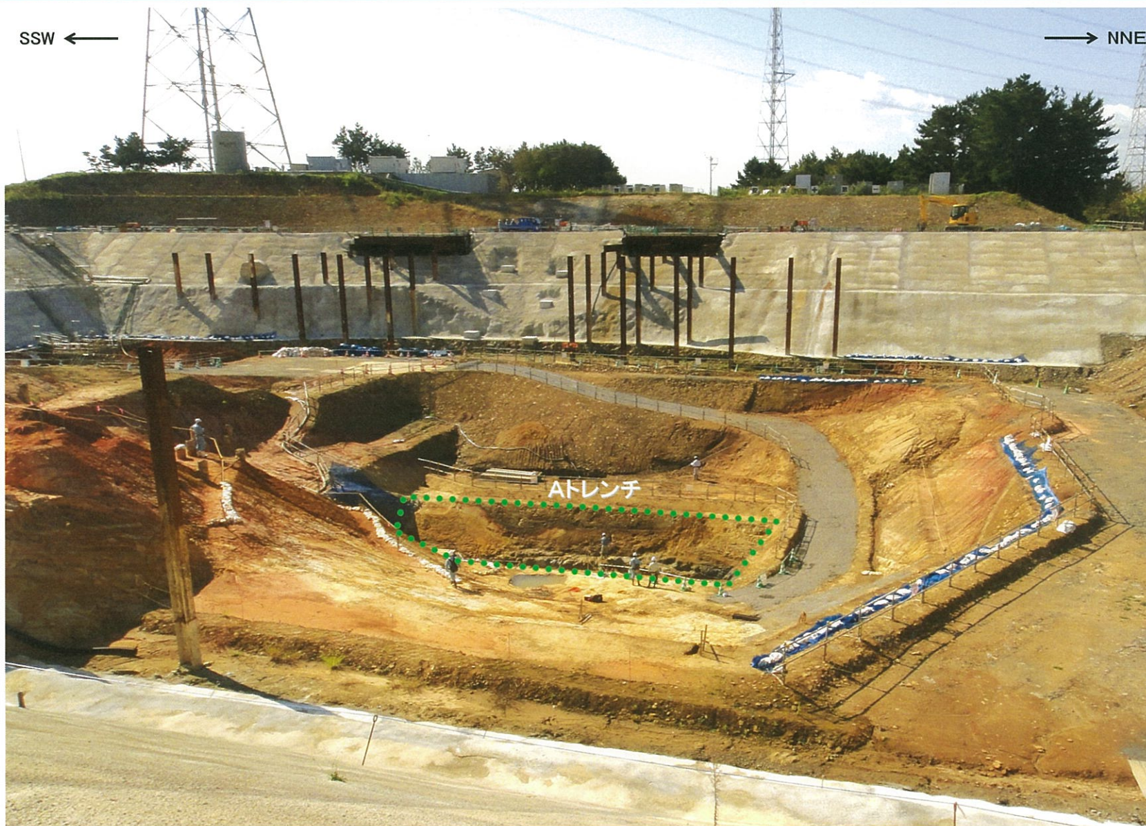
トレンチ調査位置 遠景写真
