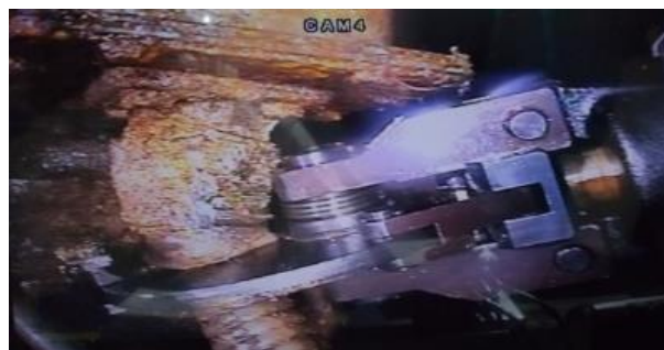
ケーブル切断の様子
