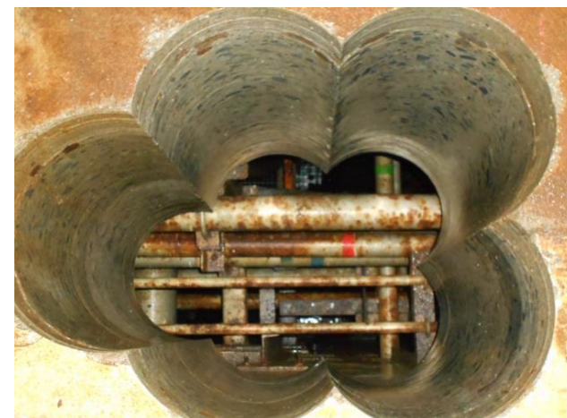
穿孔から見た地下階干渉物 (3号機R w / B床ドレンサンブA)
