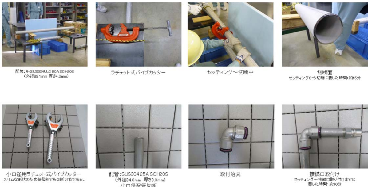
第 2. - 37 図 配管切断実証訓練
