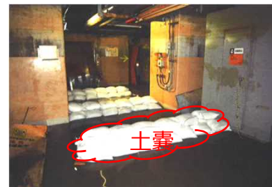
HTIの土嚢設置時の状態
