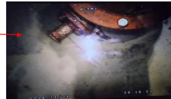
モルタル硬化の様子 (12/4)
