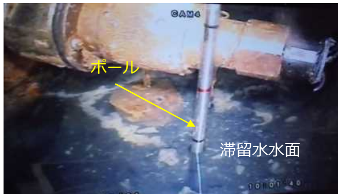
操作ポール挿入後 (12/4)
