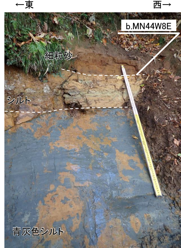
写真x 標高30m付近にみられる六ヶ所層(R) ・六ヶ所層(R)は、細粒砂と塊状なシルトからなる。
