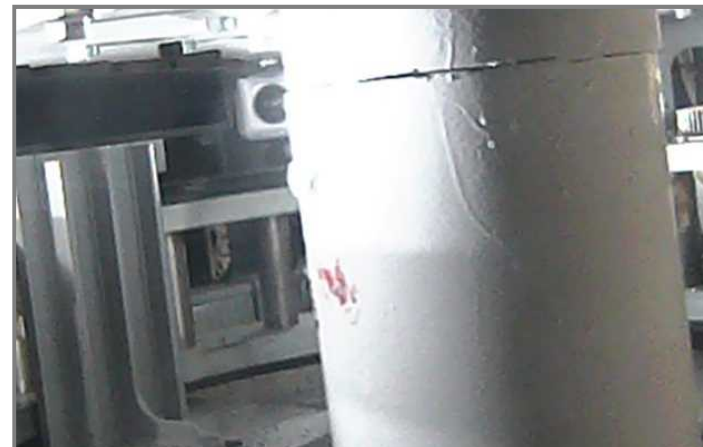
【写真④】支柱材切断状況(11月26日)
