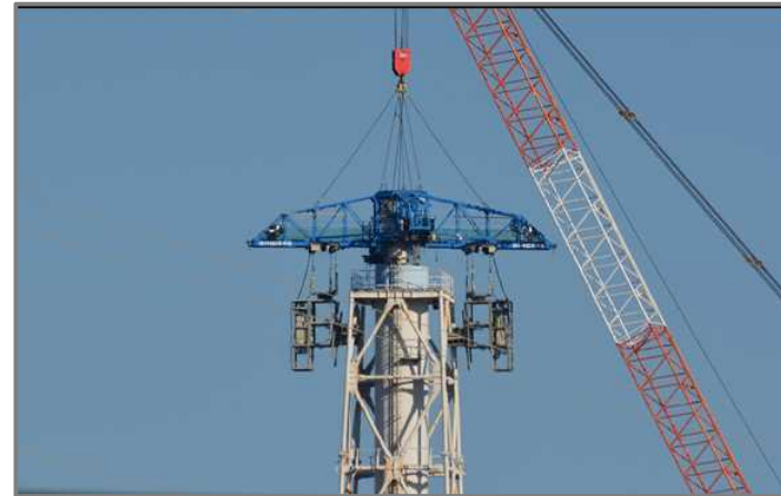
【写真②】斜材切断状況(11月6日)
