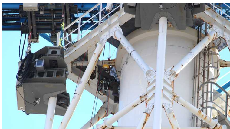
【写真⑦】筒身切断状況(12月4日)
