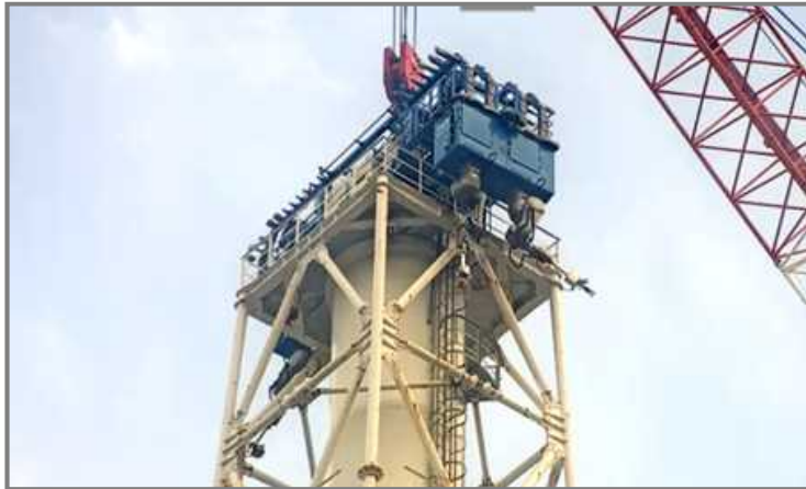
【写真①】筒身切断状況(10月27日)
