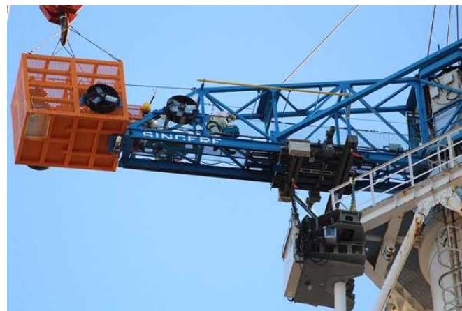
【写真⑥】給油作業の状況(12月3日)
