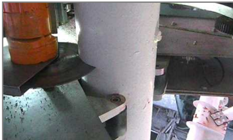
【写真③】斜材切断状況(11月7日)
