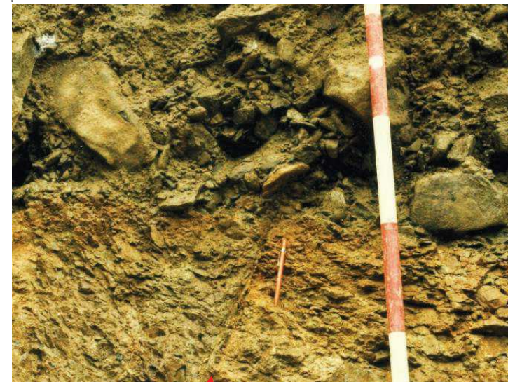
断層面を覆う第四系基底面状況(近接) (追い込み掘削箇所)
