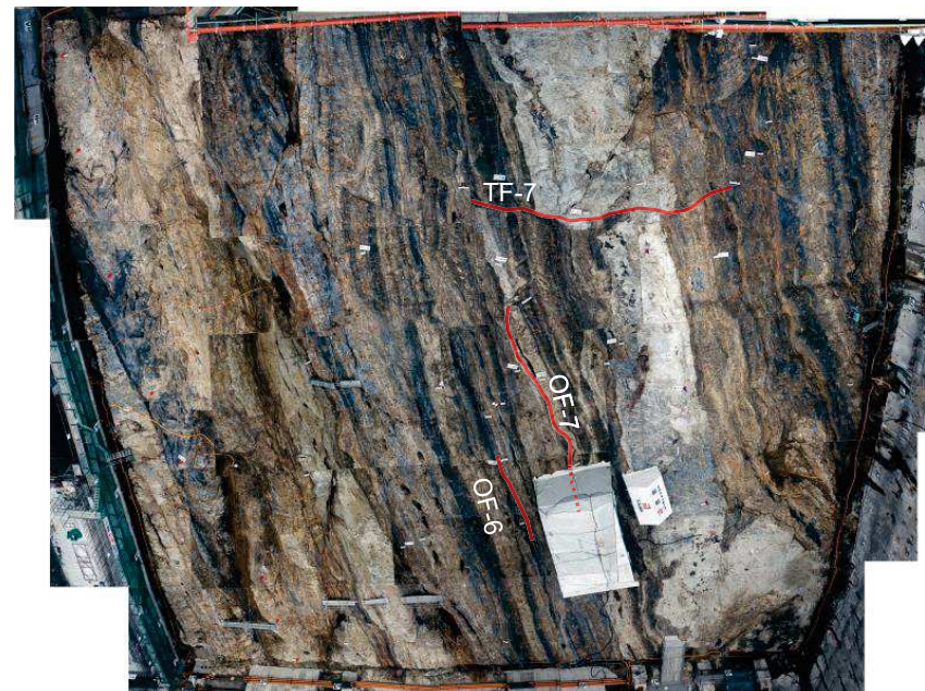
3号原子炉建屋掘削時の岩盤状況 (写真は天地を反転)
