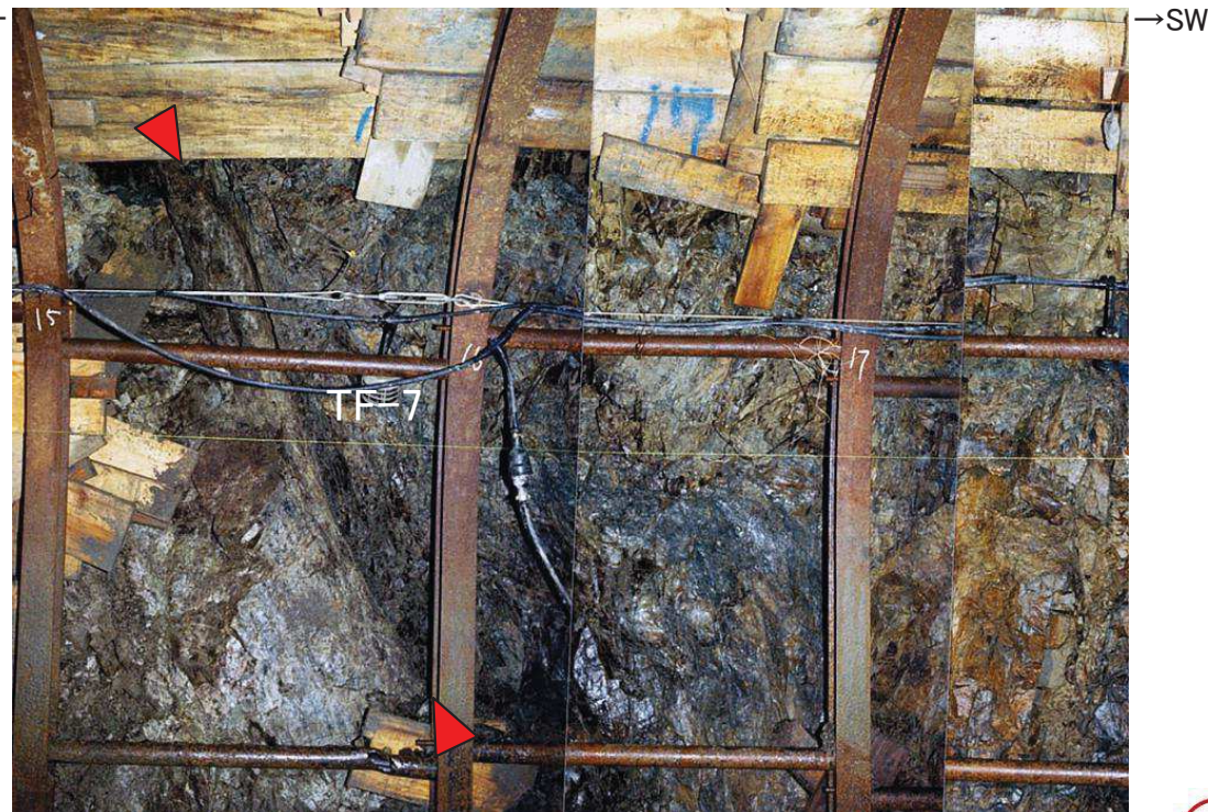
TF-7断層 3号炉試掘坑2号坑南東壁写真
