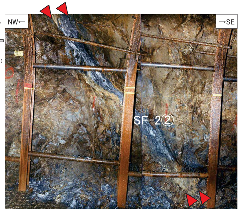
2号炉試掘坑A坑北東壁で確認したSF-2②断層(左:スケッチ, 右:写真)
