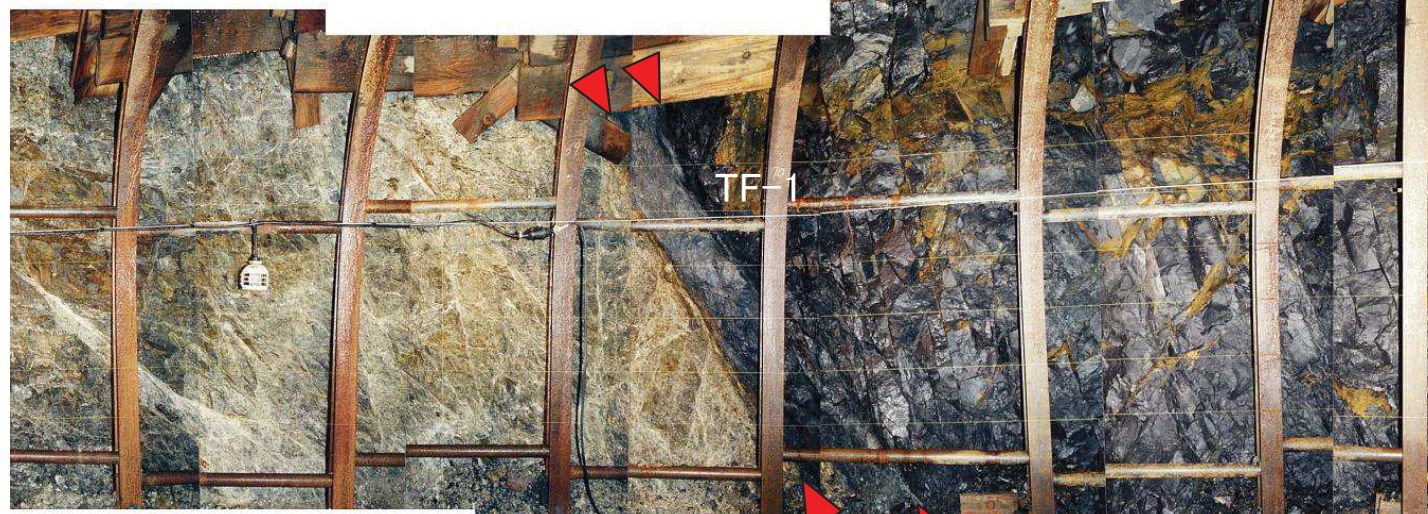
TF-1断層 3号炉試掘坑2号坑南東壁写真
