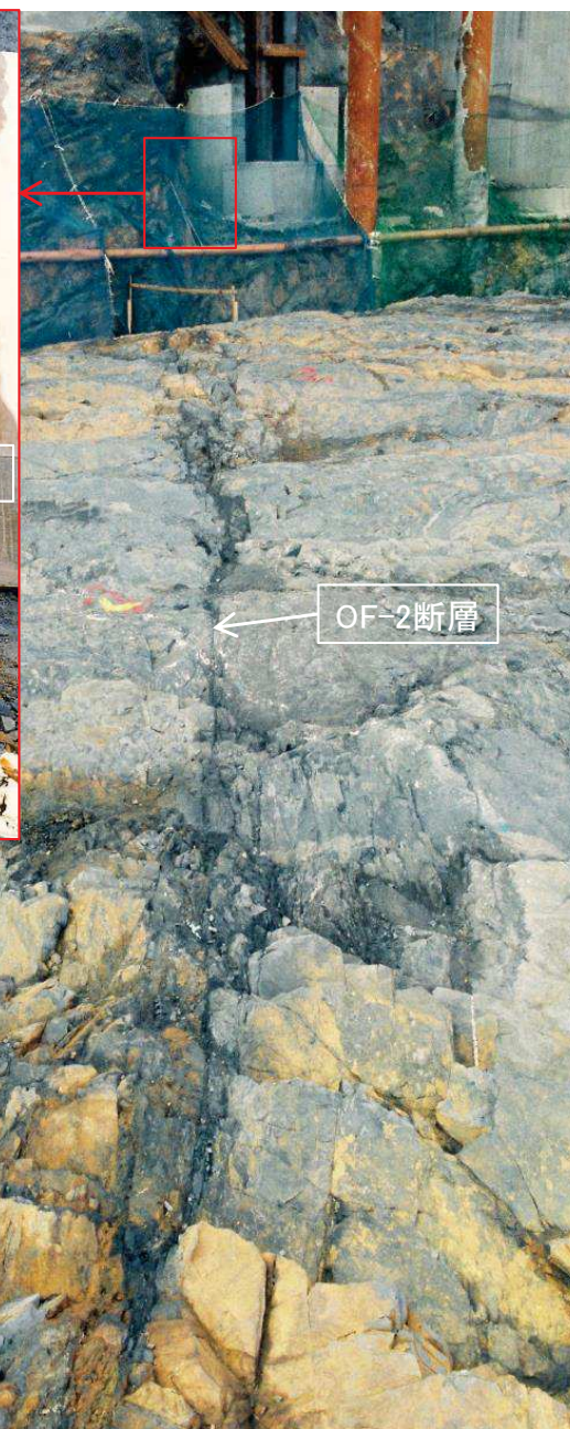
2号原子炉建屋底盤写真 (OF-2断層:東から西を望む)
