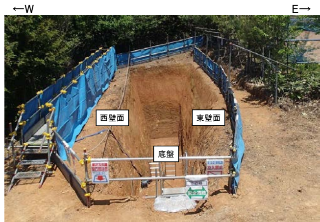
トレンチ状況写真(南側から撮影)
