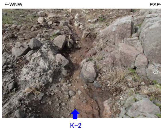
海岸部の断層の事例
