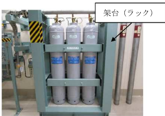
ハロン 1301 (1号原子炉補助建屋)
