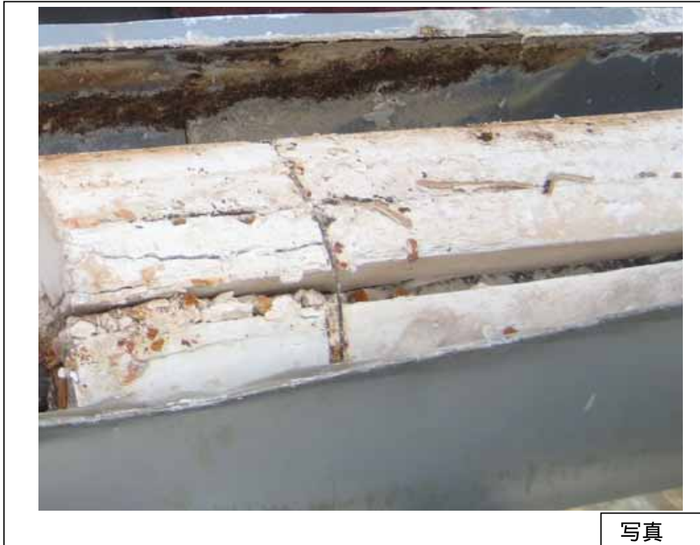
保温材外面の状況【3 B脱気器の第5 空気抜き管】
