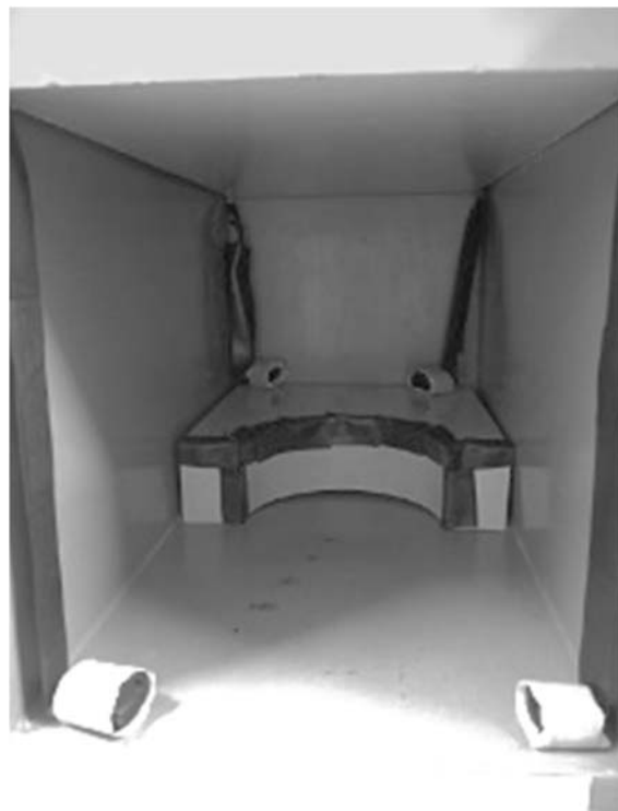
写真3 仕切り板の突起部の養生状況貯蔵棚内部
